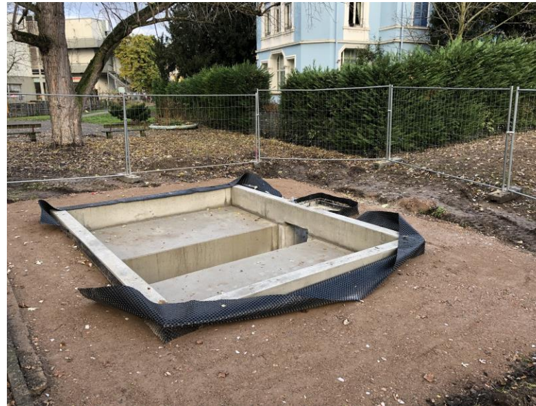
Fertige Betonwanne als Reservoir der 7 – 10 % Sole
