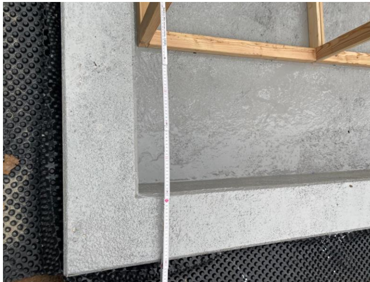
Spritzschutz – Vorbeugung Salzablagerung auf Pflasterbelag
