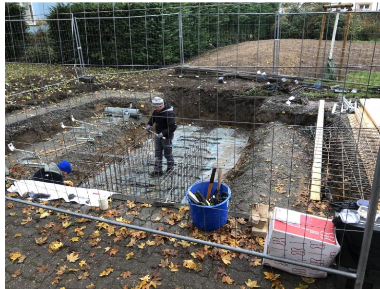
Erdaushub wurde im Park verteilt
