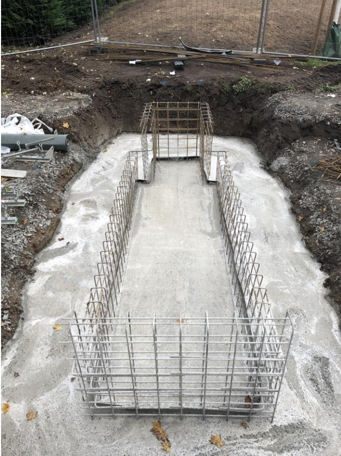
Statisch-Berechnete Armierung
