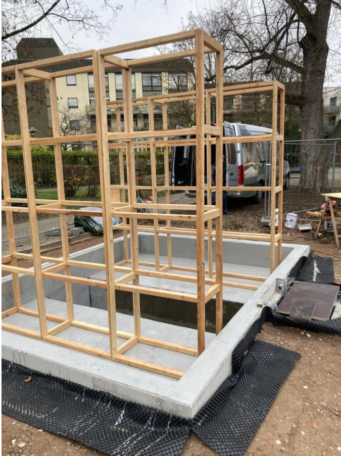
Innere Rahmenkonstruktion
