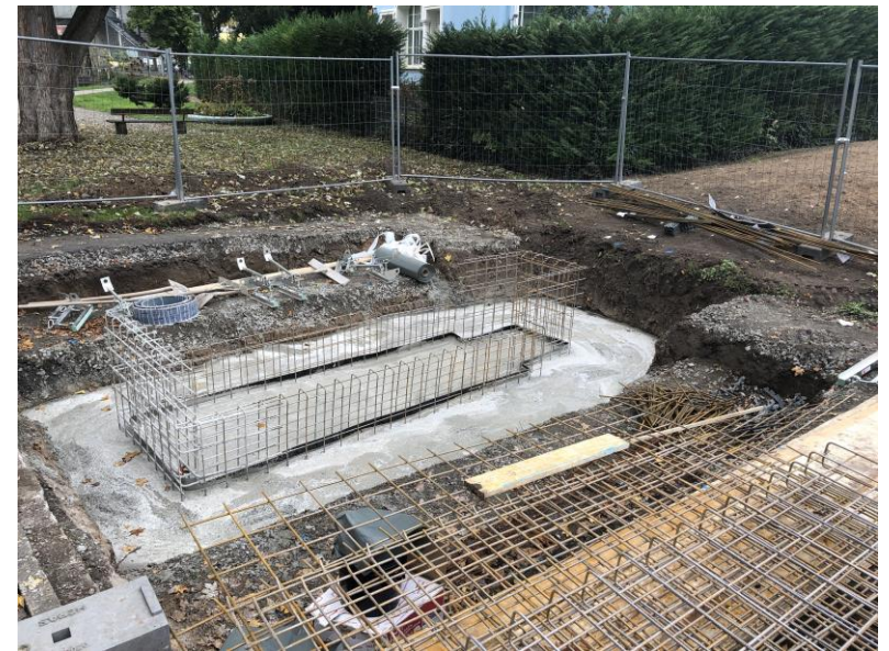
Einbau von Stahlbewehrung
