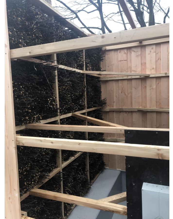
Innere Rahmenkonstruktion Aufgefüllt mit Schwarzdorn-Reisig
