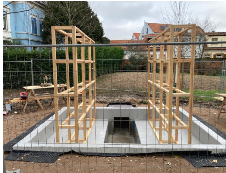
Innere Rahmenkonstruktion
